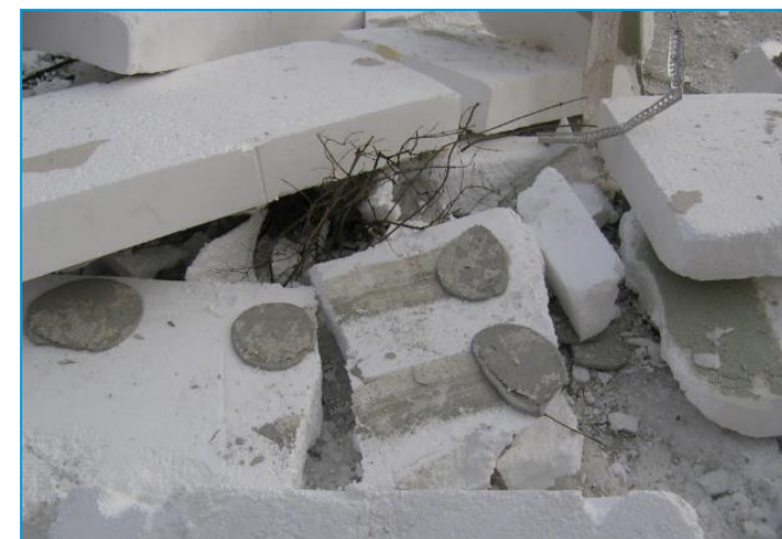
Assenza di incollaggio perimetrale
