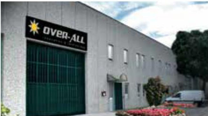
Deposito 2 - Via G. Di Vittorio - Rho
