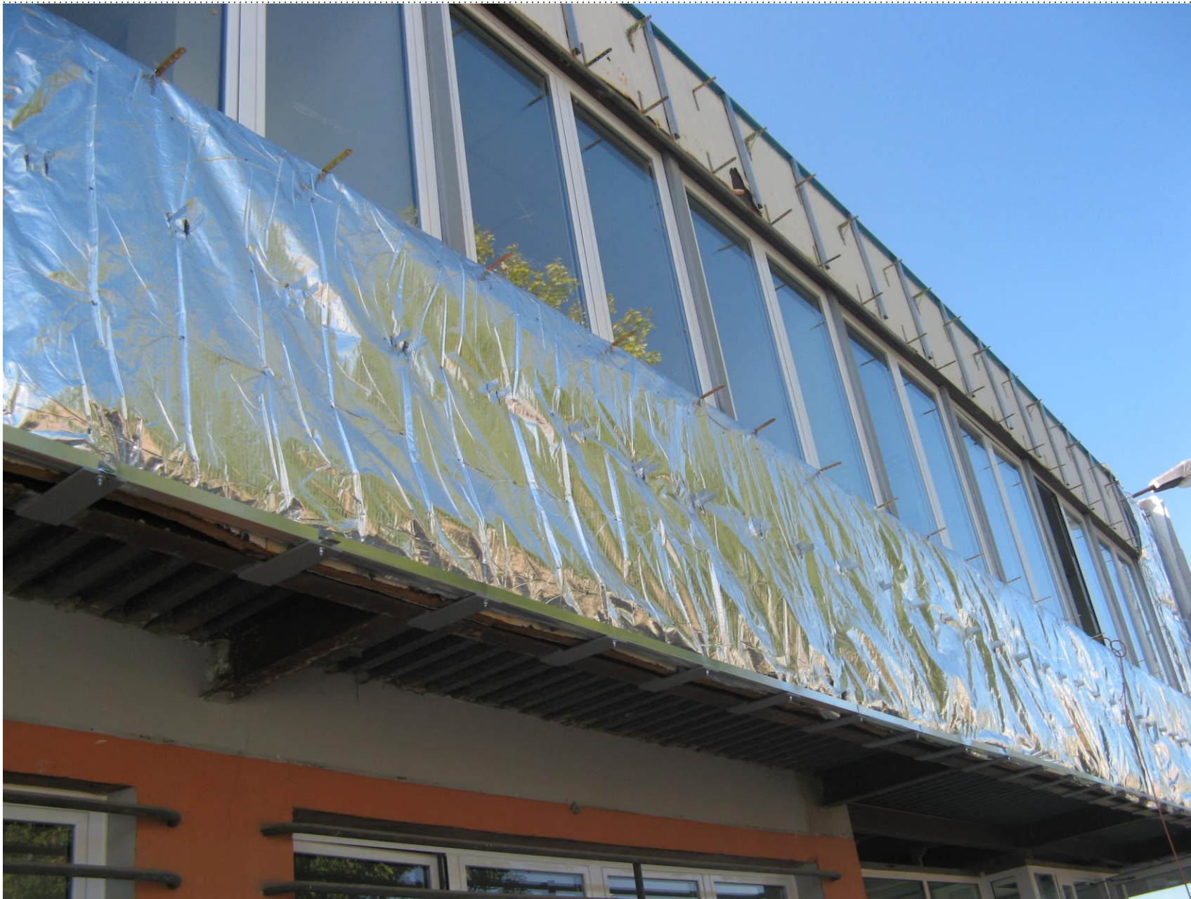
Cappotto palazzina uffici Modena
