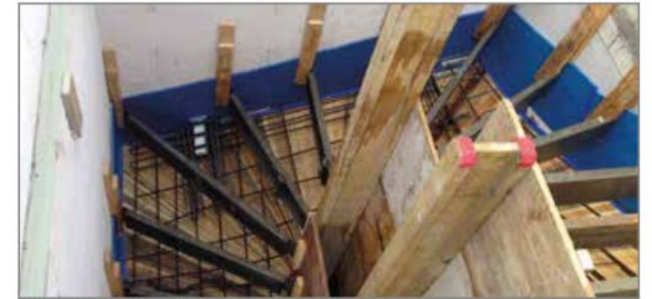
Abb. 75: Bewehrter Treppenlauf vor dem Betonieren
