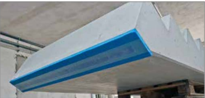
Abb. 67: Tronsole® Typ B fertig aufgeklebt
