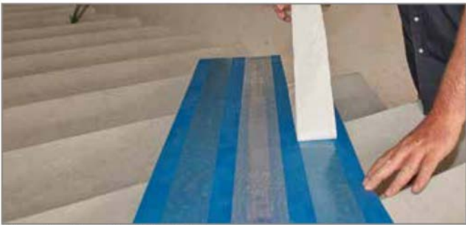
Abb. 64: Schutzfolie von Tronsole® Typ B abziehen
