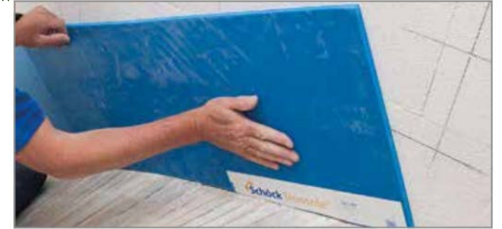
Abb. 74: Untere Hälfte von Tronsole® Typ L aufkleben
