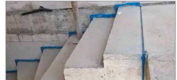
Abb. 79: Gerade Fugenausbildung am Treppenaustritt
