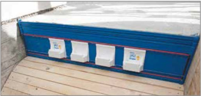
Abb. 34: Oberer Anschluss mit Tronsole® Typ I
