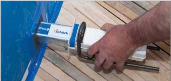
Abb. 52: Laufhülse aufstecken
