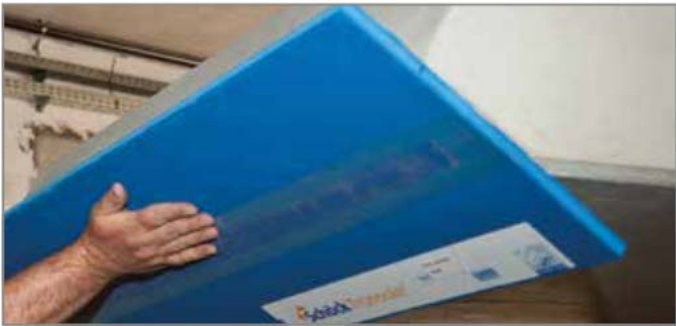
Abb. 65: Tronsole® Typ B an den Treppenuß ankleben und andrücken, sodass das Elastomerlager Elodur® mittig im Treppenuß liegt
